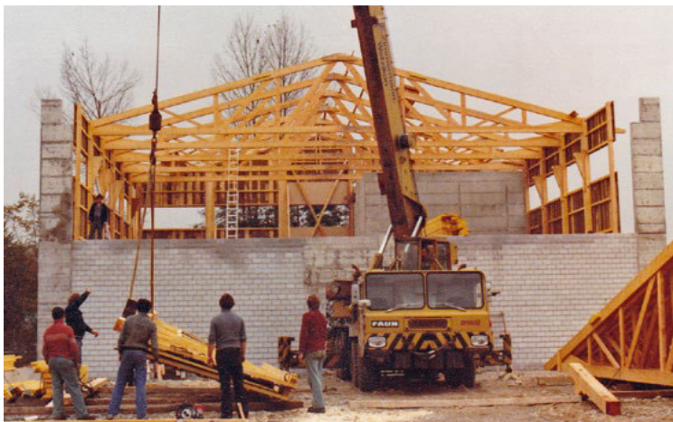
Baubeginn des Neubaus und Neueinrichtung des Maschinenparks, 1979.
